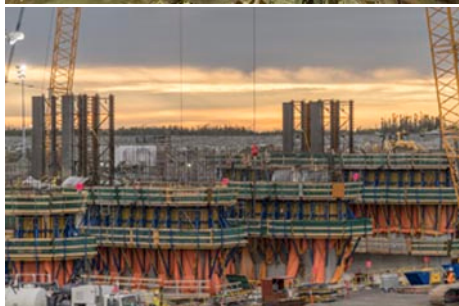
Nosníkové debnenie Top 50S je vďaka svojej mnohostrannosti ideálnym riešením pre rovné steny a malé polomery pri výstavbe prepádov.
