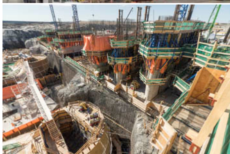
Priehradové debnenie D22 a nosníkové debnenie Top 50S od spoločnosti Doka sa používajú pri výstavbe sacieho potrubia a prepádov.
