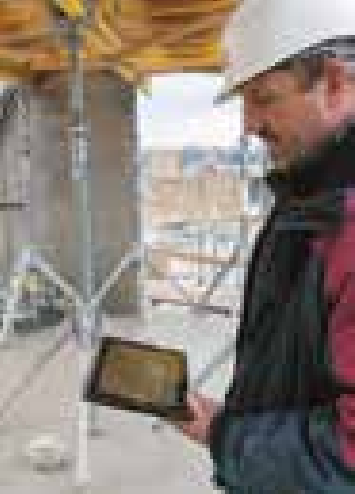
Festigkeitsmessung des Betons in Echtzeit mit Concremote
